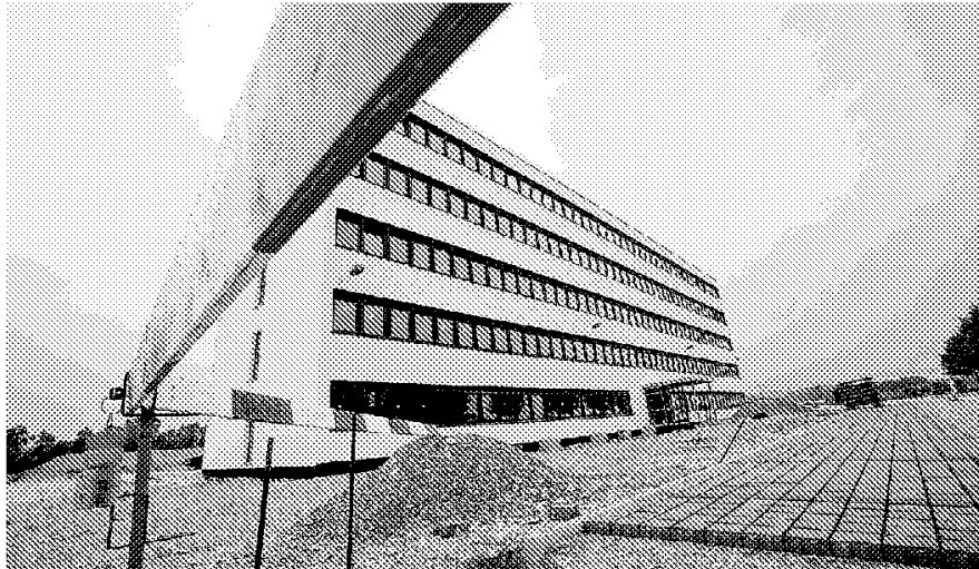
Grossbaustelle Weinfelden: Der Firmensitz ist fast fertig, an allem anderen wird noch fleissig gearbeitet.
